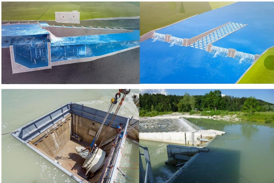
Figura 92: Visualización del concepto Hydro Shaft (línea superior) y 450 kW en Grossweil, Alemania (línea inferior) (Fuente: línea superior: UTM y línea inferior: A. Sepp)
