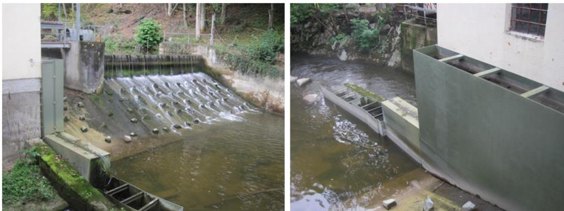
Figura 81: Esclusa para peces en la PH Jeging 2, Austria. (fuente: M. Schletterer)
