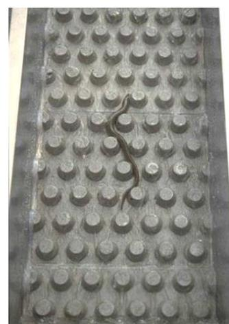
Figura 79: Rampa para anguilas cubierta por un estrato tipo cepillo (izquierda) y (derecha) un estrato de conos de hormigón (fuente: AFB)
