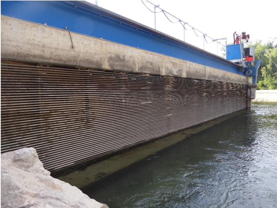
Figura 88: El bastidor de barras horizontales de la HP de flujo residual Schiffmühle, Suiza, durante la extracción del yacimiento en julio de 2018 (Fuente: J. Meister, VAW)
