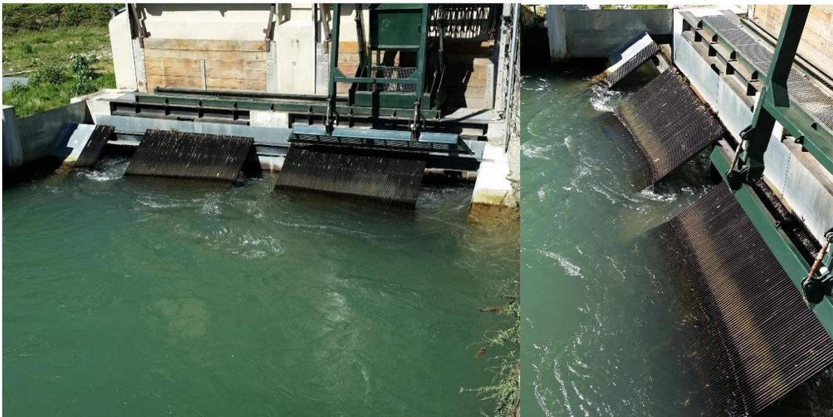
Figura 87: Bastidor de barras inclinado con aberturas al sistema de canal de bypass (Fuente: P. Rutschmann)
