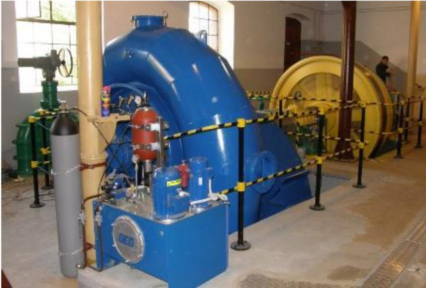
Figura 20: Moderna turbina Francis en una central hidroeléctrica Polaca rehabilitada (fuente: archivos IMP PAN)
