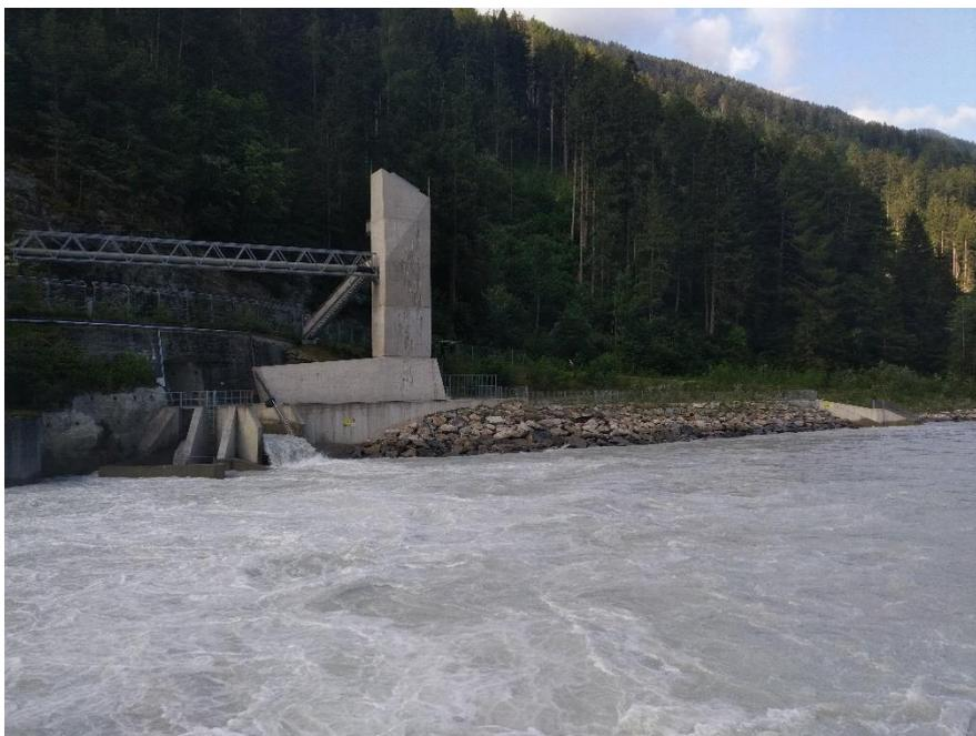
**Figure 80:** Ascenseur à poissons de Runserau, Autriche (source : M. Schletterer)
