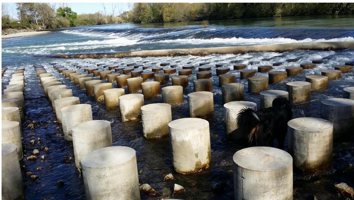
Figure 77: Combinaison de différents types de rampes, avec des éléments en béton au premier plan et une rampe raide et rugueuse en arrière-plan (source : P. Rutschmann)
