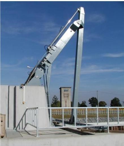
Figure 59: Dégrilleur articulé de la PCH de Januskowice - Rivière Oder, Pologne (source : J. Steller)
