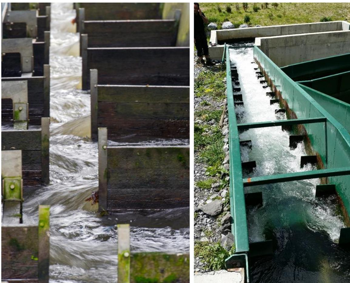
Figure 76: Passe à poissons de type piscine (à gauche) et à déflecteur raide (Denil) (à droite)
