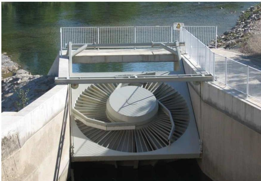
Figure 32: Une unité très basse chute à la sortie du canal Milleau (Leclerc, 2008)
