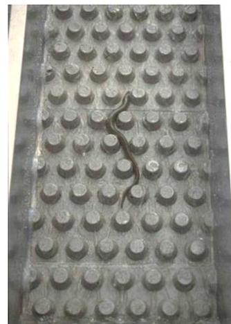
Figure 79: Rampe à anguille recouverte d'un substrat de type brosse (à gauche) et (à droite) d'un substrat de cônes en béton (source : AFB)
