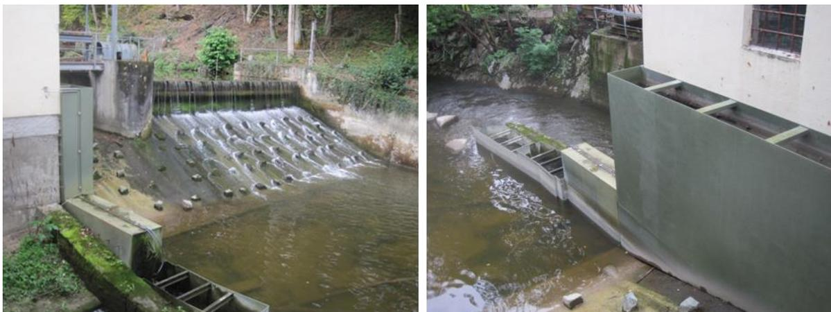
Figure 81: Écluse de poisson à la CH Jeging 2, Autriche (source : M. Schletterer)
