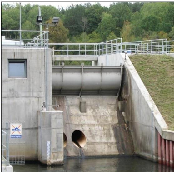
Figure 64: Vanne clapet articulée à la crête du seuil à la PCH Rzczyca - Rivière Wierzyca, Pologne (source : J.Steller)
