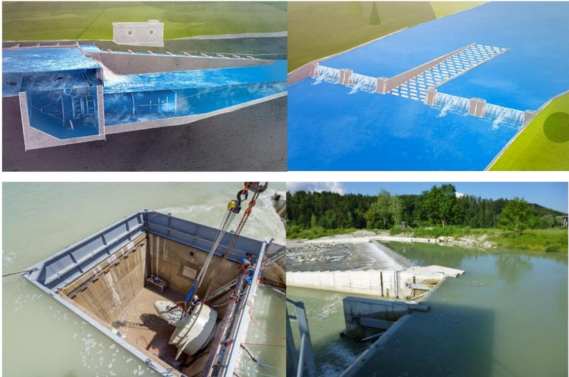
Figure 92: Visualisation du concept Hydro Shaft (ligne du haut) et 450 kW à Grossweil, Allemagne (ligne du bas) (source : ligne du haut: TUM et ligne du bas : A. Sepp)
