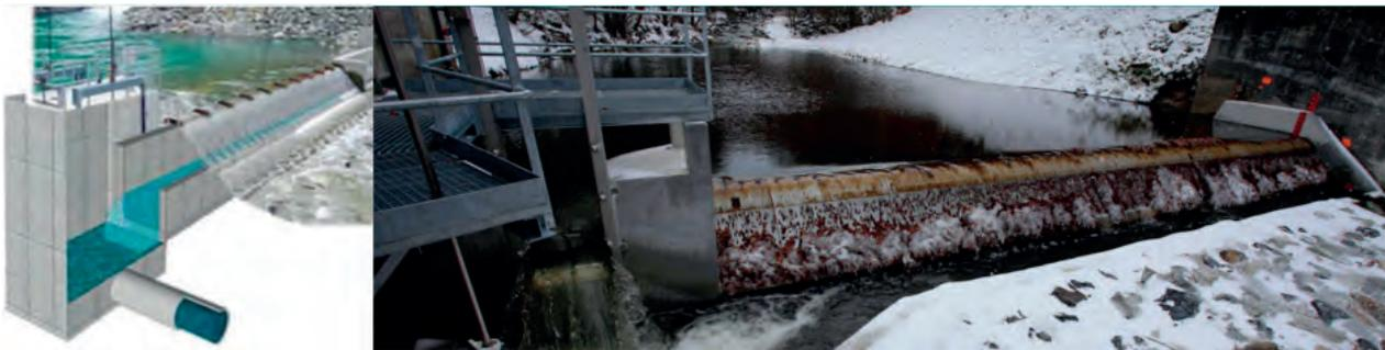
Figure 91: Illustration de la prise d'eau de Coanda et exemple de prise d'eau de Coanda d'Escouloubre (977 m d'altitude) sur l'Aude, France (source : AFB)
