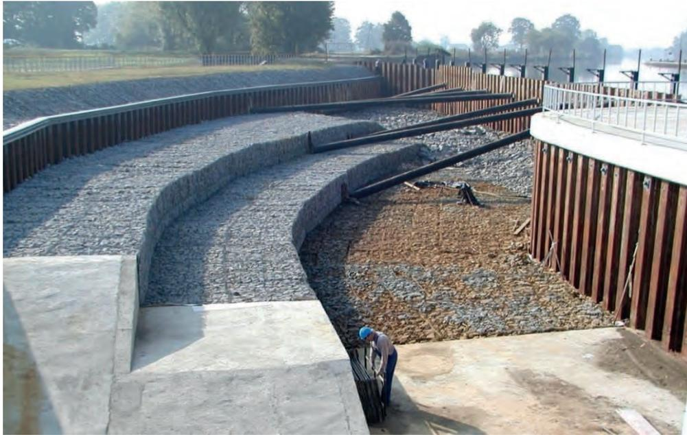
**Figure 7: Façonnage du canal d'entrée de la PCH de Januszkowice (1.5 MW) -Rivière Oder, Pologne (source : archives IMP PAN)**
