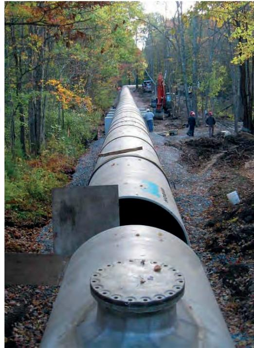
Figure 73: Structure de tuyau Flowtite (à gauche) et remplacement d'un segment de conduite forcée en bois par un pipeline Hobas PRV (à droite). Jackman Hydro Station, Hills-borough, New Hampshire, États-Unis (Amiblu, 2020)
