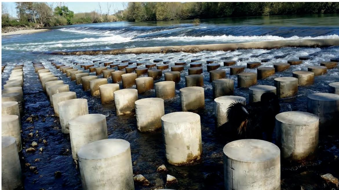
Figure 77: Combinaison de différents types de rampes, avec des éléments en béton au premier plan et une rampe raide et rugueuse en arrière-plan (source : P. Rutschmann)
