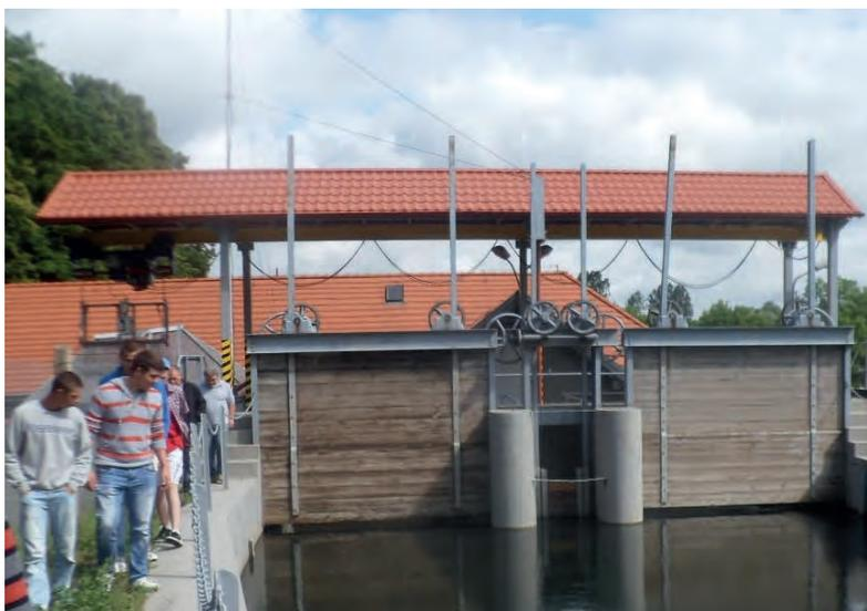
**Figure 61: Prise d'eau de la PCH de Rutki – Cascade Radunia, Pologne (source : archives IMP PAN)**
