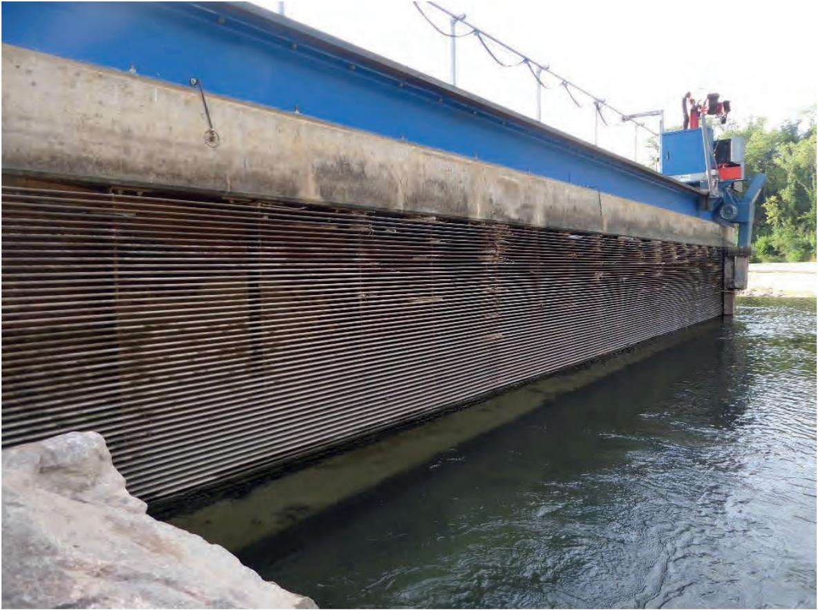
Figure 88: La grille à barres horizontales de débit résiduel de la centrale de Schiffmühle, Suisse, lors de la vidange du réservoir en juillet 2018 (source : J. Meister, VAW)
