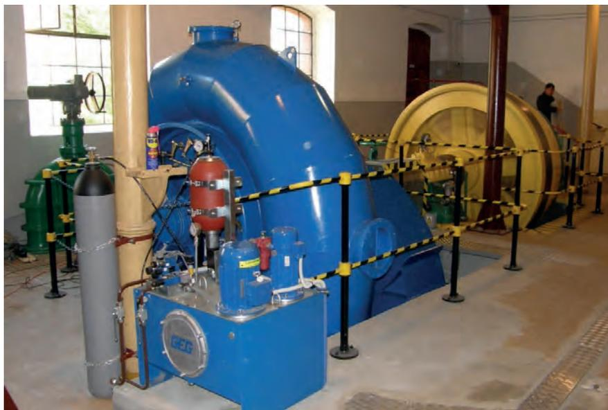
Figure 20: Une turbine Francis moderne dans une centrale hydroélectrique polonaise rénovée (source : archives IMP PAN)
