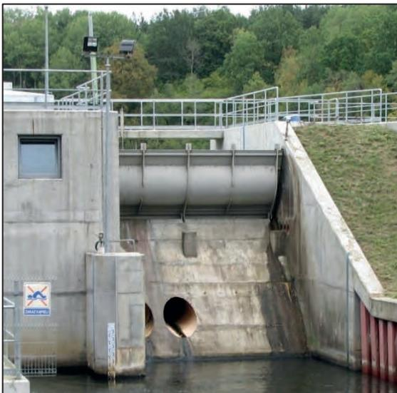
Figure 64: Vanne clapet articulée à la crête du seuil à la PCH Rzczyca - Rivière Wierzycza, Pologne (source : J. Steller)
