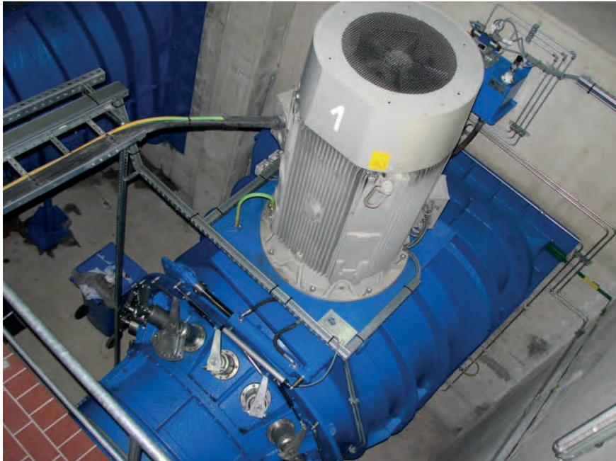
Figure 30: Une unité compacte typique avec un multiplicateur de vitesse à engrenages coniques. Oborniki SHP, Pologne (source : archives IMP PAN)
