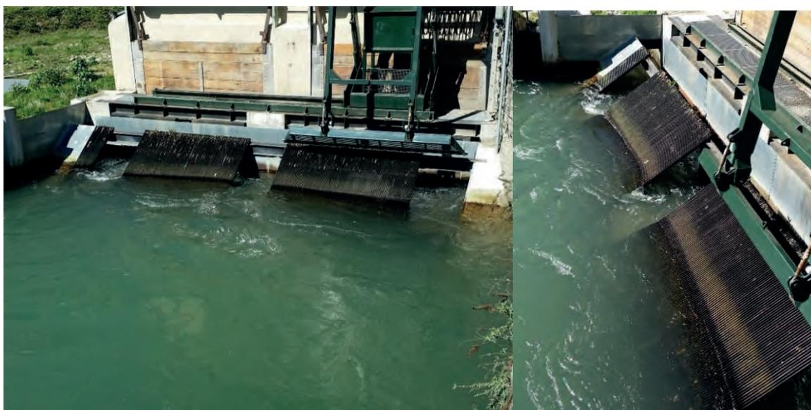
Figure 87: Grilles à barres inclinées avec ouvertures pour le système de canaux bypass (source : P. Rutschmann)
