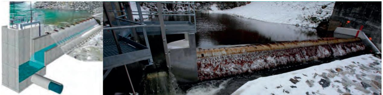
Figura 91: Ilustración de la toma de agua de Coanda y ejemplo de la toma de agua de Coanda de Escouloubre (977 m de altitud) en el río Aude, Francia (Fuente: AFB)
