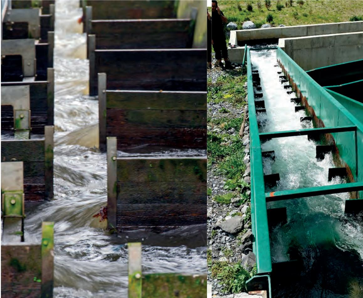
Figura 76: Paso de peces tipo piscina (izquierda) y tipo deflector empinado (Denil) (derecha) (Fuente: J. Geist, P. Rutschmann)
