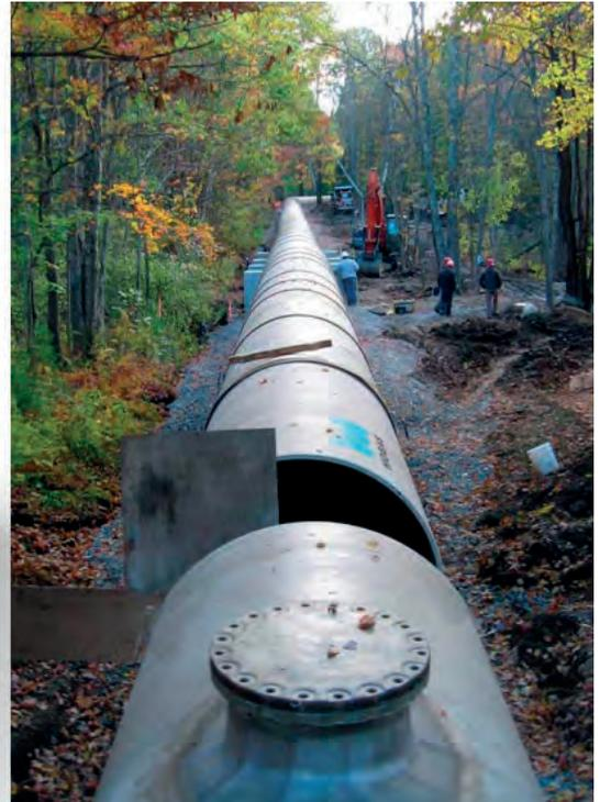
**Figura 73:** Estructura de la tubería Flowtite (Izquierda). Sustitución de un segmento de tubería forzada de madera por una tubería de PRFV Hobas (derecha). Estación hidroeléctrica Jackman, Hillsborough, New Hampshire, EE. UU. (Amiblu, 2020)
