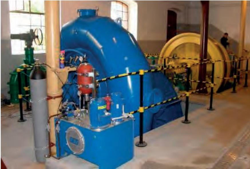
Figura 20: Moderna turbina Francis en una central hidroeléctrica Polaca rehabilitada
