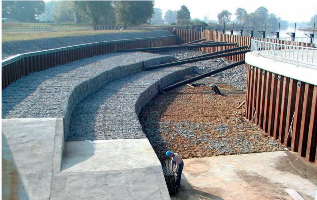
**Figura 7:** Forma del canal de entrada de la Pequeña Central Hidroeléctrica de Januszkowice (1,5 MW) – Río Oder, Polonia (Fuente: archivos IMP PAN)
