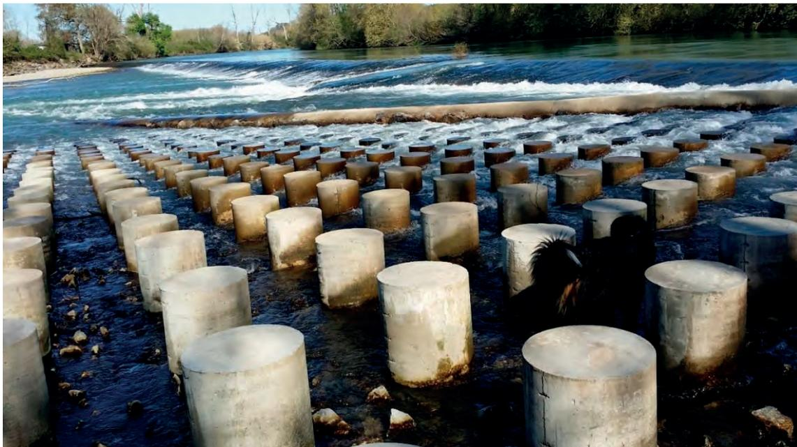
Figura 77: Combinación de diferentes tipos de rampas, con elementos de hormigón en primer plano y rampa empinada y rugosa en el fondo (Fuente: P. Rutschmann)
