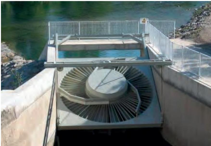
Figura 32: Unidad TMBA (Turbina de muy baja altura) en la salida del canal Milleau (Leclerc, 2008)
